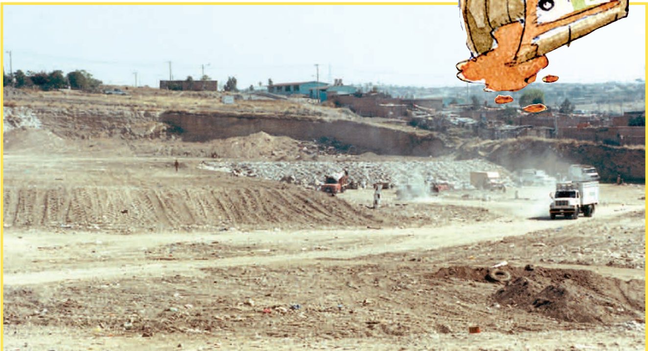
Relleno sanitario en Aguascalientes.
